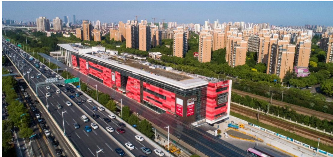
「ららステーション上海蓮花路」建物外観
