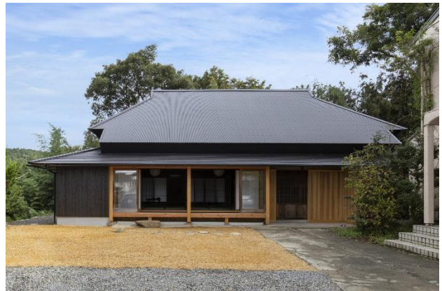
リフォーム部門「大賞」受賞作「日野町の古民家」 有限会社ネヌケンさま（滋賀県甲賀市）施工
