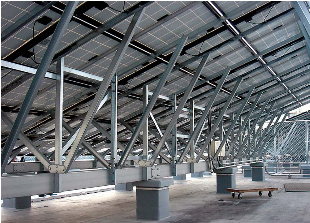
スーパーダイマ®のソーラーパネル架台使用例
