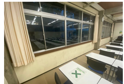
改修工事 実施教室
