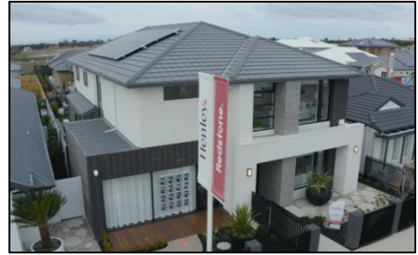
太陽光パネルを搭載した住宅(写真は展示場)
