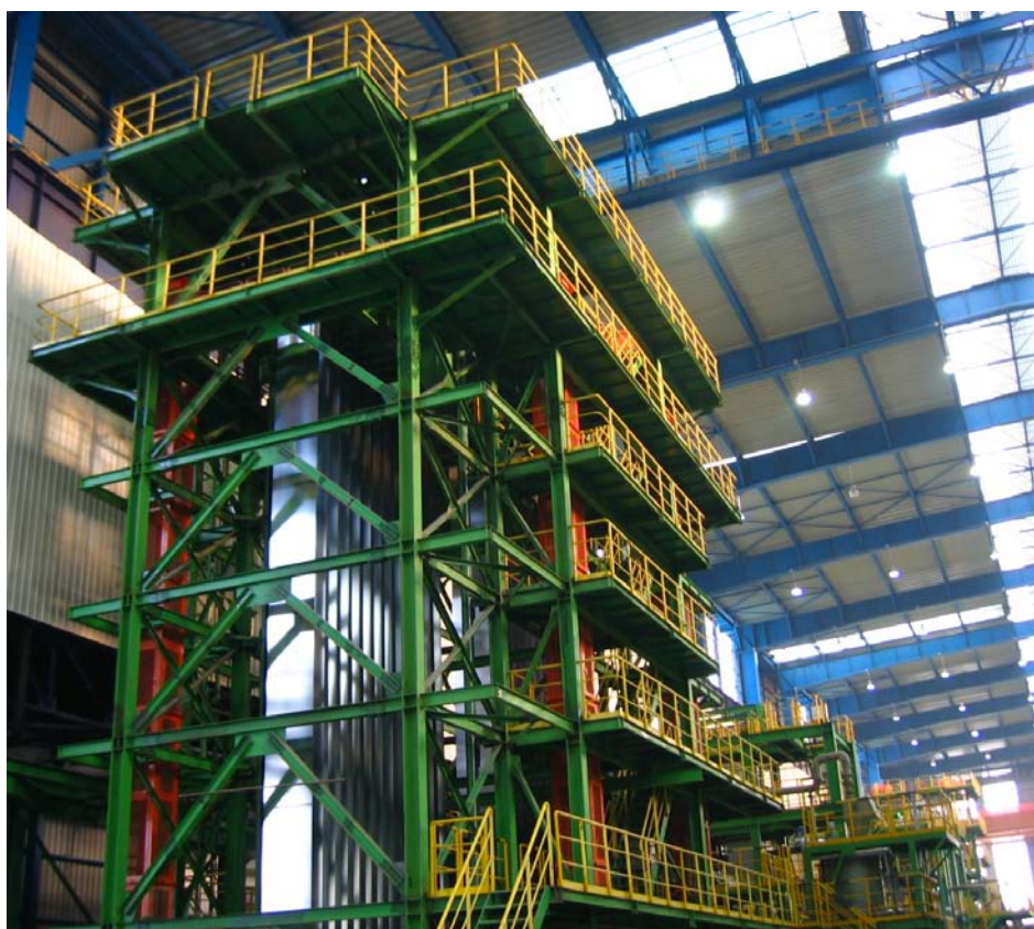
WINSteel 電気錫めつき設備(ETL)
