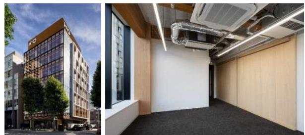
CLT耐震壁と乾式遮音壁の複合壁にすることで、事務所の利便性を損なうことなく、耐震性・遮音性を向上させました。
