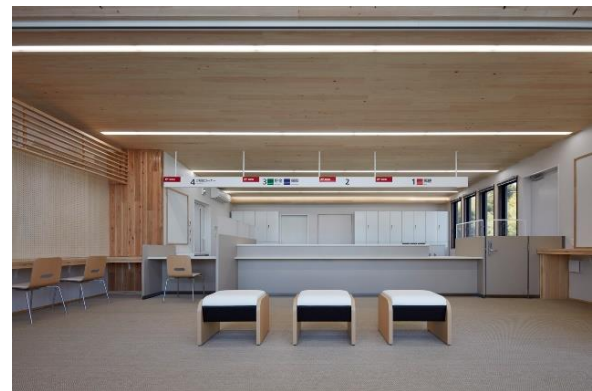
天井や家具にCLTを活用し木質感のある空間に
