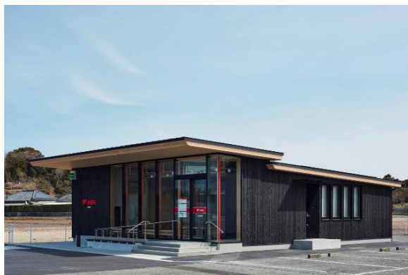
大きな庇と焼杉の外壁が印象的な外観
