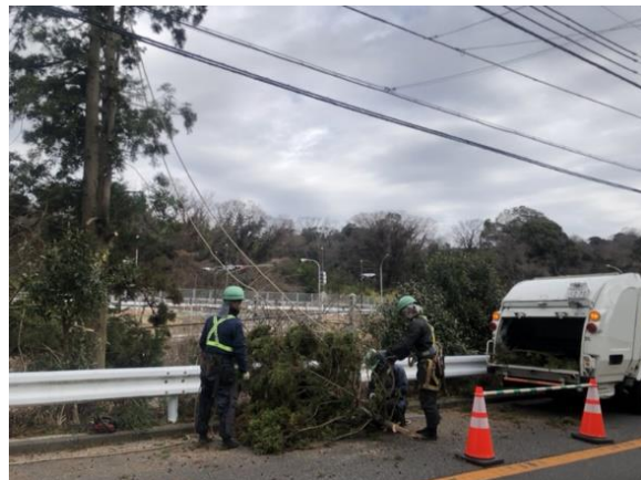
線路付近伐採の様子
