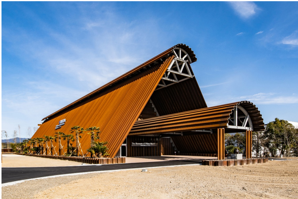
創造館（世界杭打機ミュージアム）
