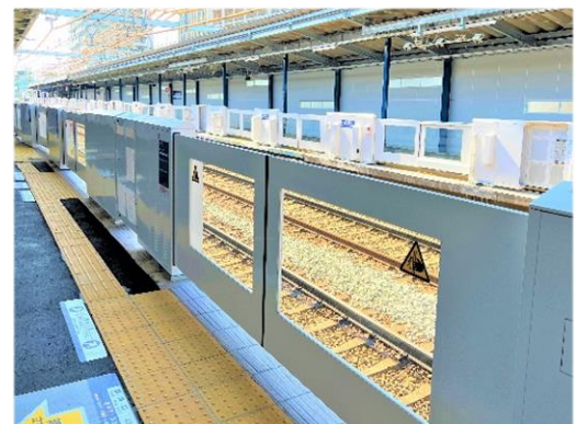
<設置例（京急東神奈川駅下りホーム）>
