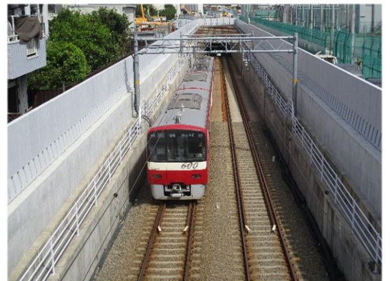
<地上部整備の現況>
