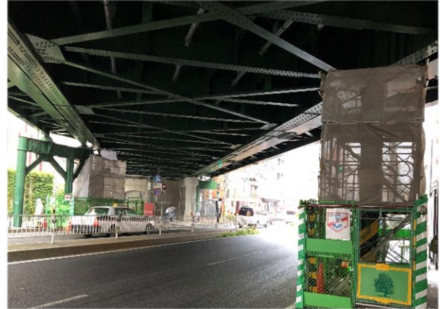
<日ノ出町駅付近架道橋橋脚補強工事>
