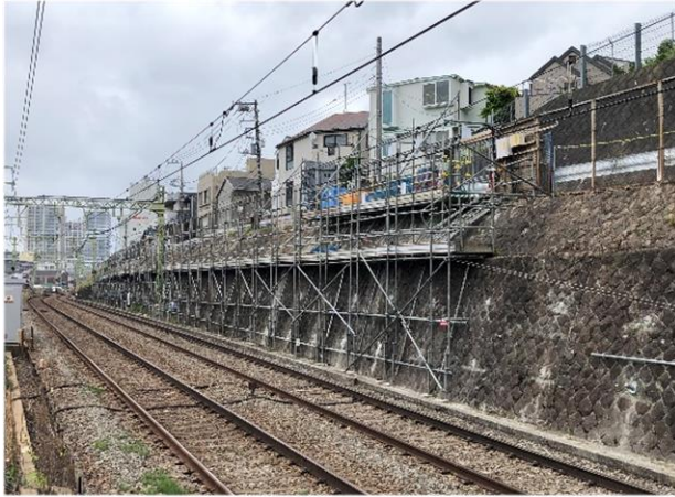
<神奈川駅付近石積擁壁補強工事>
