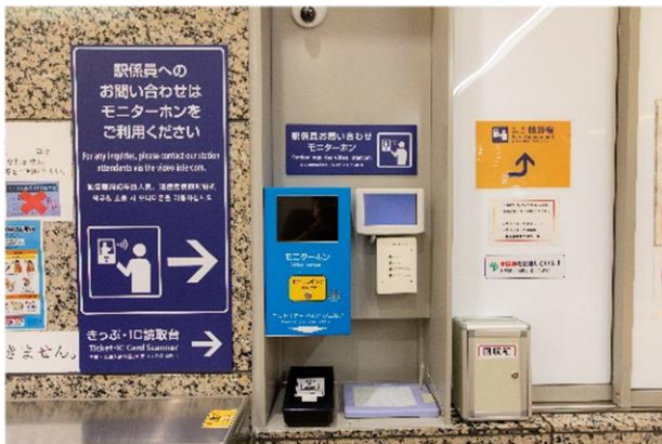
<駅遠隔監視システム>
