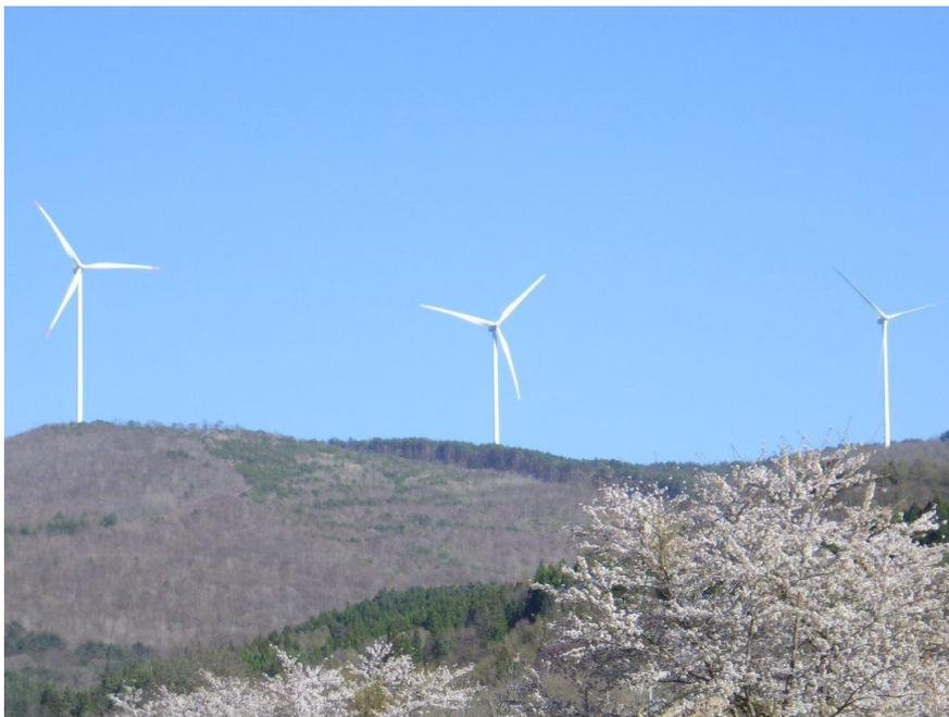
本発電所は、岩手県遠野市および住田町の両自治体に位置し、単機出力4,200kWのベスタス社製風力発電機を27基設置、総出力は113,400kWとなります。発電機は大船渡市の大船渡港から陸揚げされ、現場への輸送、据付、建設等の工事請負は清水建設株式会社が行いました。これは一般家庭の約84,000世帯相当分（参考：遠野市と住田町の総世帯数は約12,000世帯）の電力供給に相当し、年間約10万トンの二酸化炭素削減効果（参考：遠野市と住田町の家部門の令和2年度CO<sub>2</sub>排出量は約5万トン
