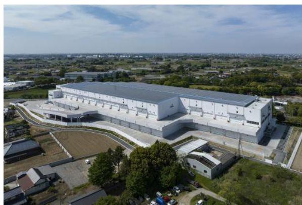
「加須ロジスティクスセンター」外観
