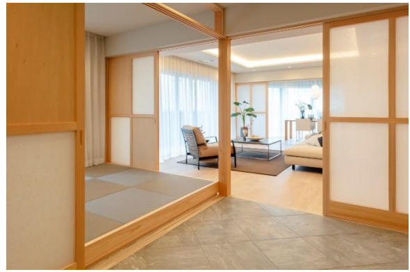
玄関から続く土間はタイル仕上げ
