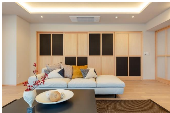
建具は布張りと板張りの「可動建具」で製作
