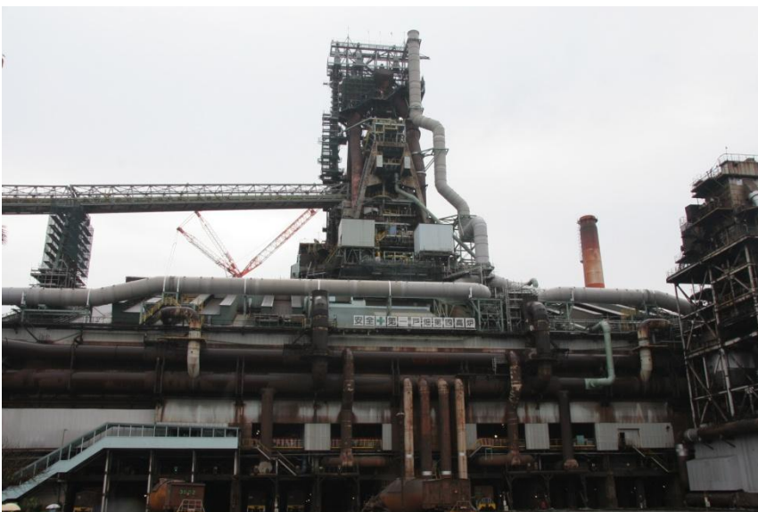
改修後の戸畑第4高炉
