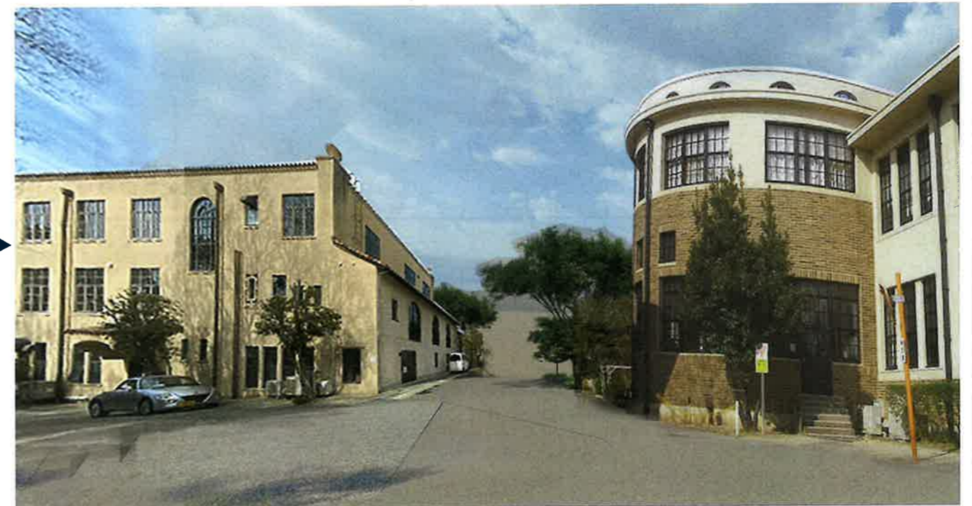
完成後:視界が広がり、重要文化財が引き立つ
