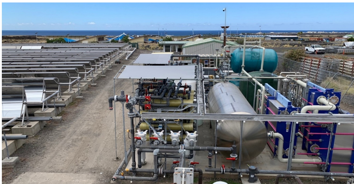
写真1 Trevi Systems 社のハワイ島の海水淡水化 FO システム実証試験装置
