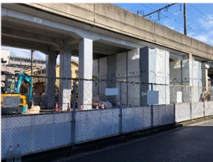
<弘明寺～上大岡駅間高架橋耐震補強工事>
