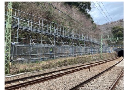
<六浦～神武寺駅間法面防護工事>
