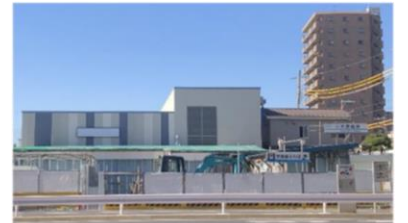
<大師橋駅の現況>
