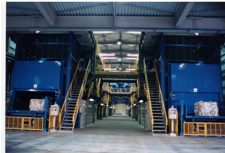
(容器包装プラスチックの事前処理設備)
