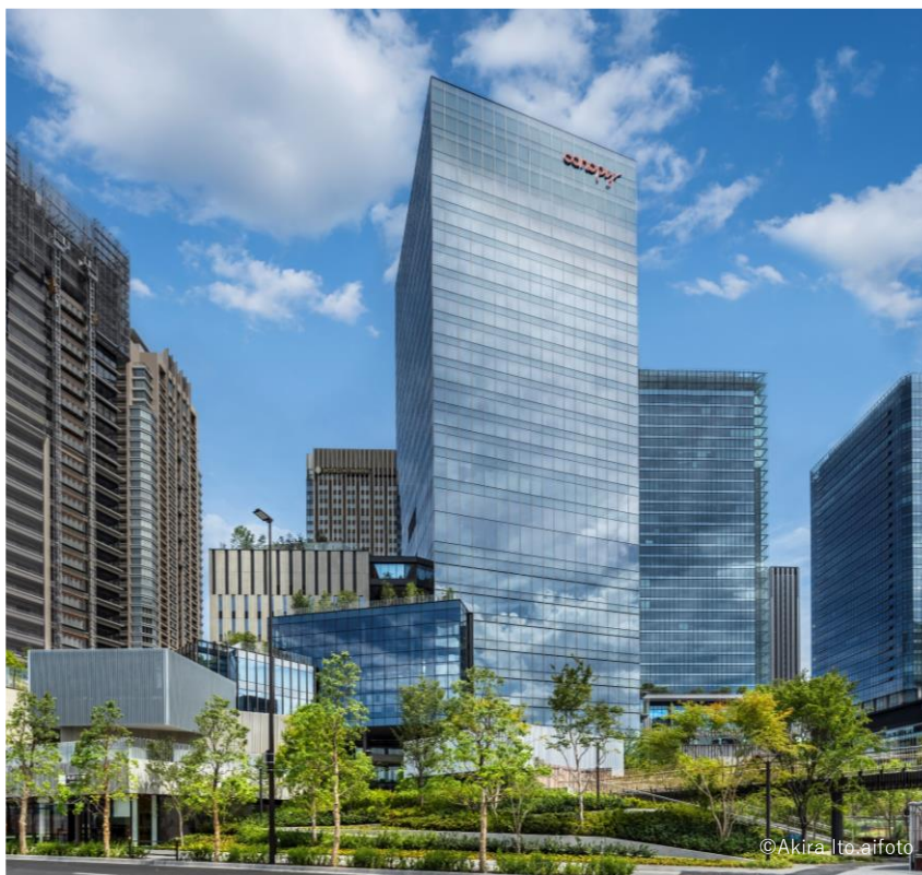
ランドスケープと一体となった北公園施設と北館
