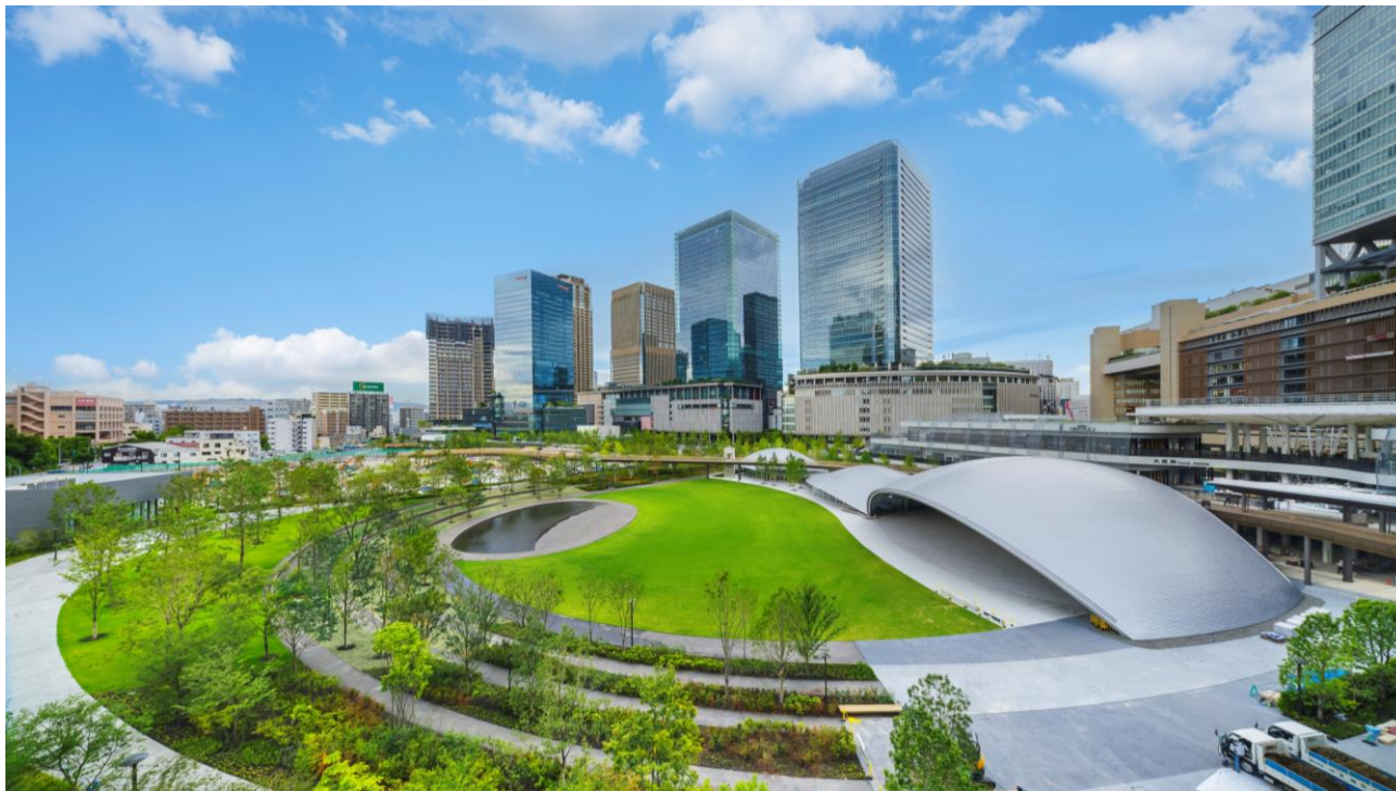
先行まちびらきを迎えるグラングリーン大阪「うめきた公園」 南館テラスよりサウスパーク越しに北館を望む
