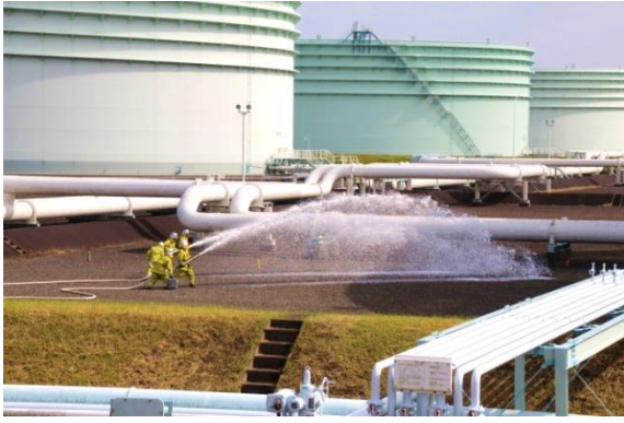
自衛防災組織(消防隊)の泡消火訓練
