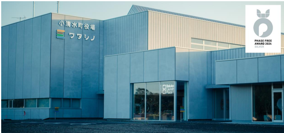
小清水町防災拠点型複合庁舎「ワタシノ」 「PHASE FREE AWARD 2024」シルバー(事業部門: ファシリティ/教育・文化・公共施設)
