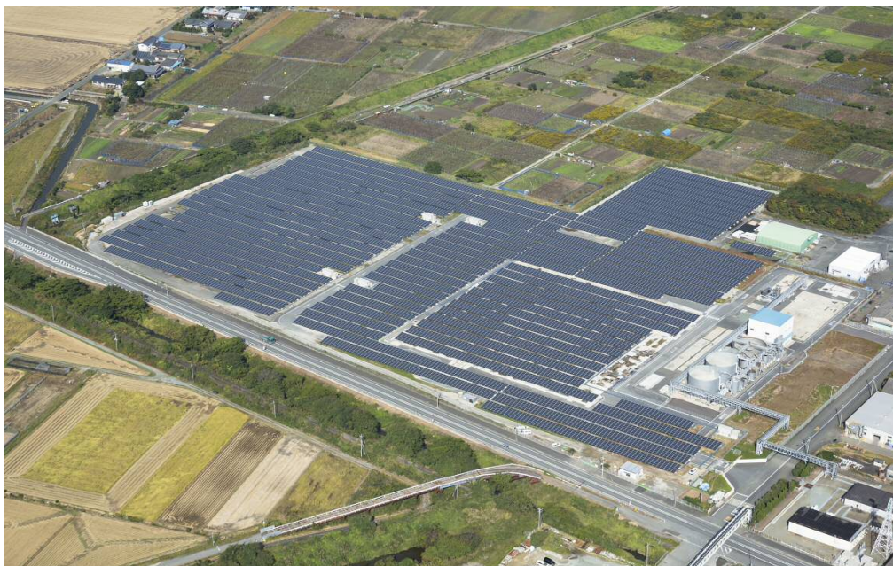
三井不動産大牟田太陽光発電所 空撮写真
