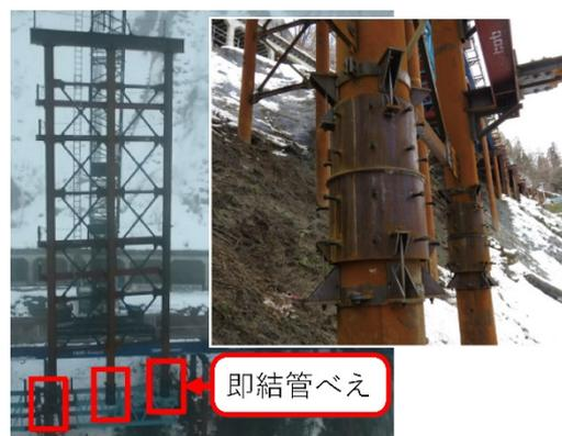
機械式継手「即結管べえ®」による省力化、工期短縮
