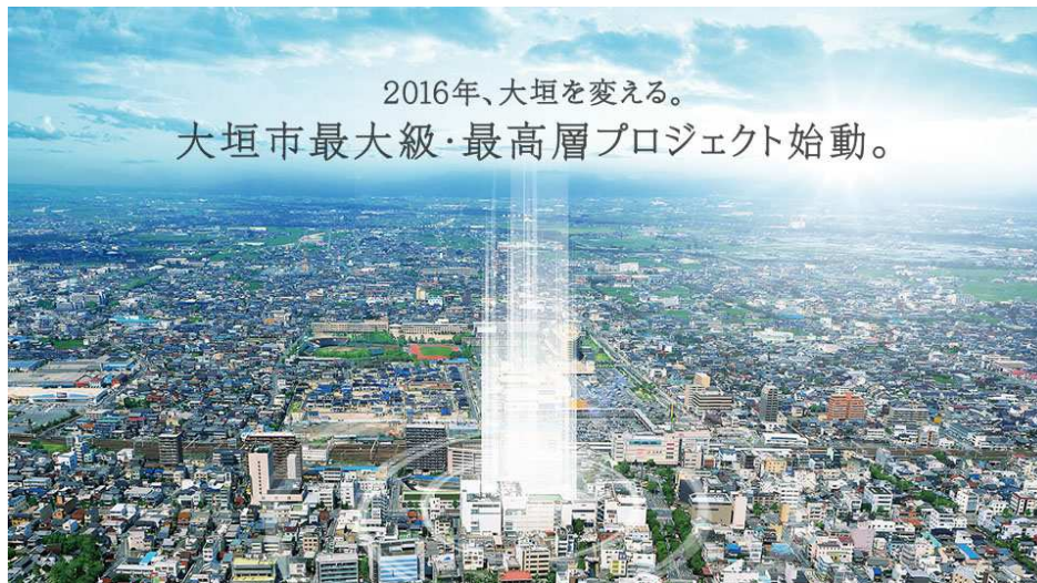
「ライオンズ大垣駅前ローレルタワー」建設地周辺の空撮写真
